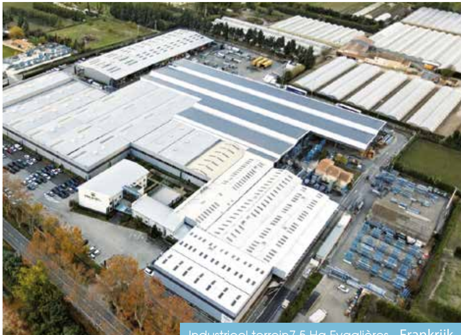
Industrieel terrein 7.5 Ha Eygalières - Frankrijk
